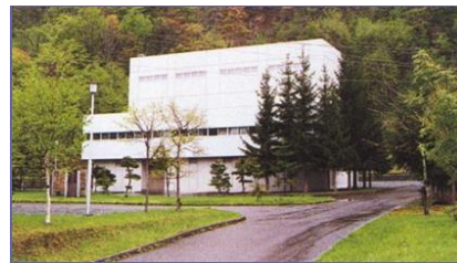
豊平峡発電所
