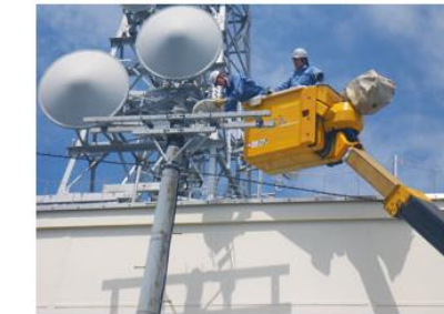
測量山ライトアップ機器清掃
