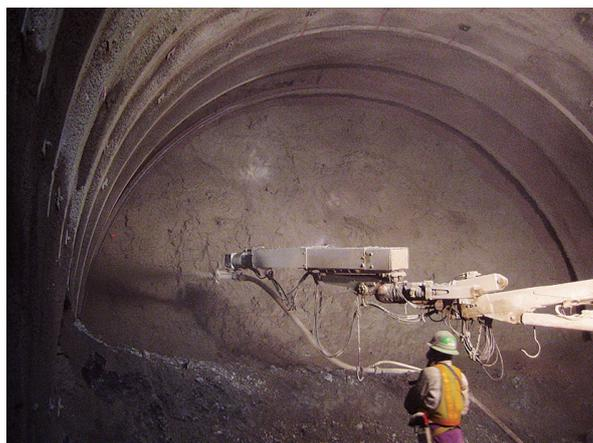
トンネルの吹き付けコンクリート施工
