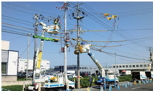
電柱建替に伴う移線作業
