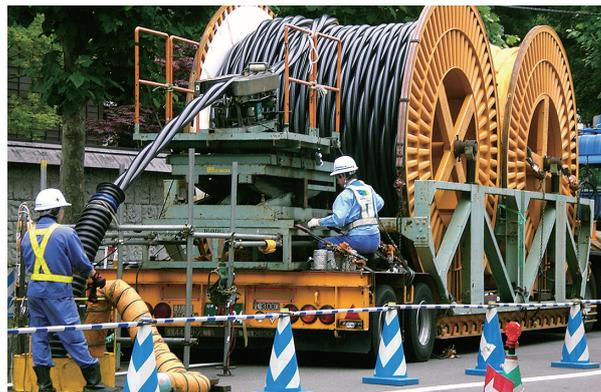
電力ケーブル(66kV)引入れ作業
