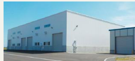
PCB処理施設（苫小牧リサイクルセンター）
