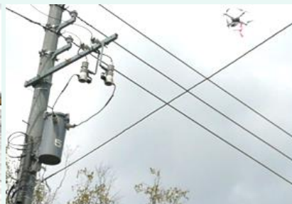
ドローンによる設備確認
