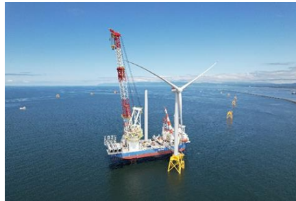
【建設工事の様子】
