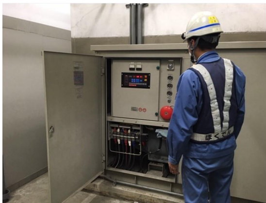
【非常用発電設備の操作手順確認】
