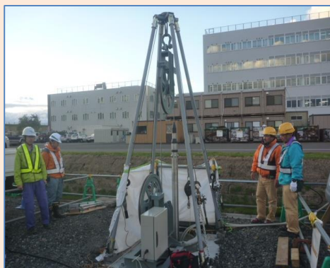
深部地震計設置状況 標高-4m、標高-500m、 標高-1170mに深部地 震計を設置しました。
