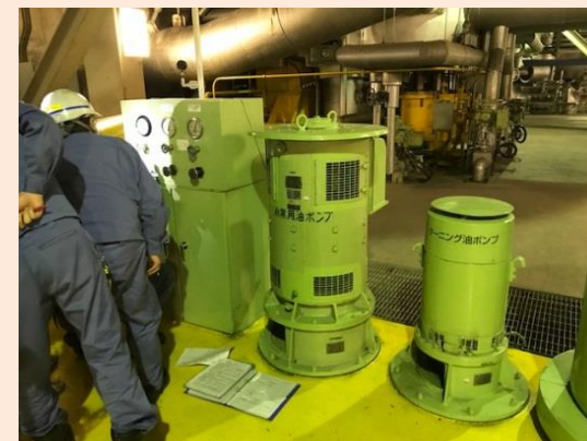
火力発電所における研修 装置起動確認(運転員)
