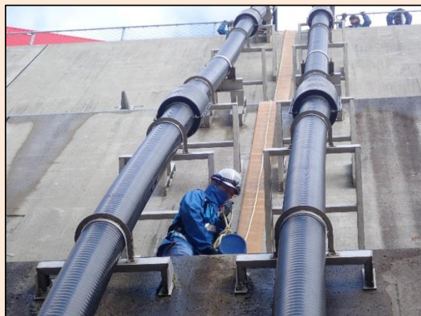
可搬型大型送水ポンプ車による注水訓練 (法面でのホース敷設)
