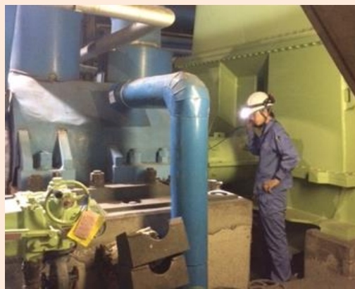
火力発電所における研修 大型ポンプの聴音(保修員[機械])
