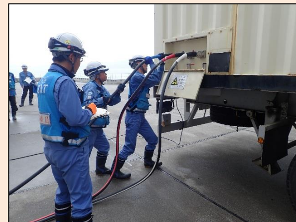
可搬型代替電源車による給電訓練
