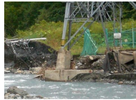
無線鉄塔基礎部の 被害
