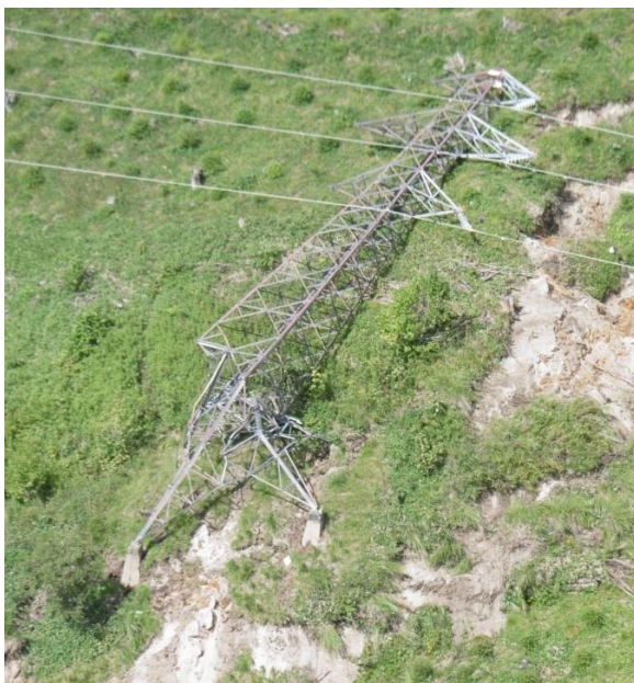
鉄塔倒壊箇所(岩知志線)
