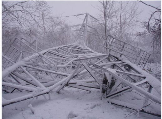
送電線 鉄塔倒壊
