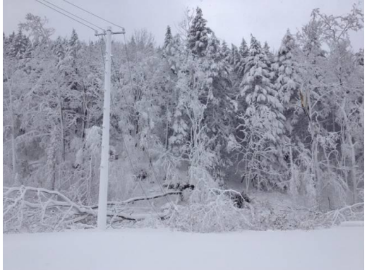
樹木倒壊による 高圧線断線
