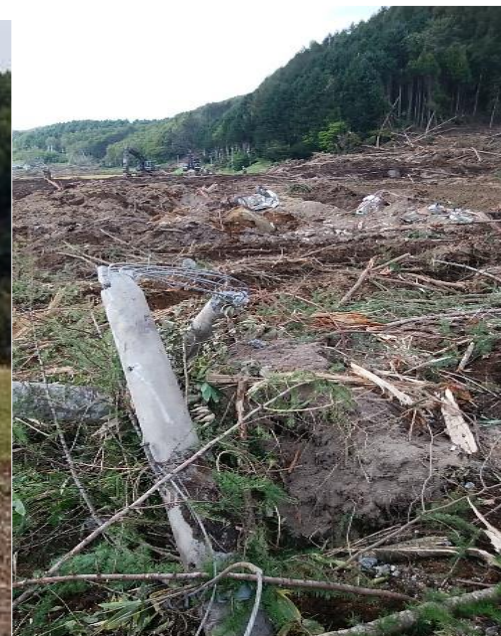
土砂崩れによる電柱流失
