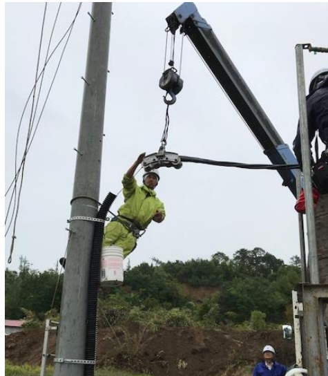
高圧ケーブルによる応急送電
