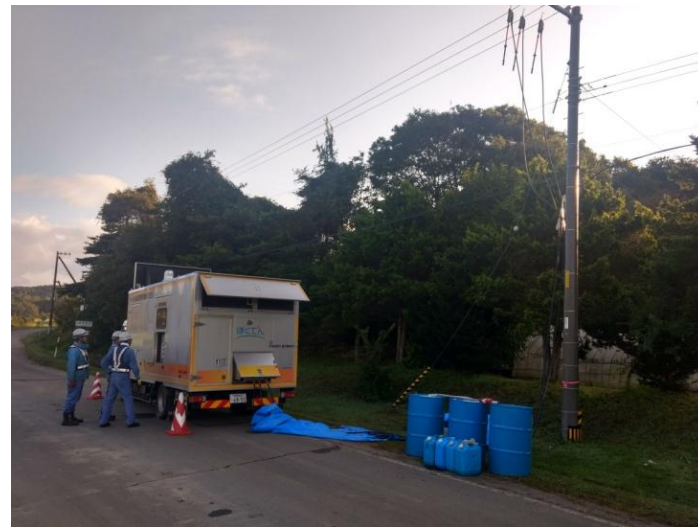
移動発電機車による応急送電
