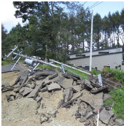
倒壊した柱上変圧器柱
