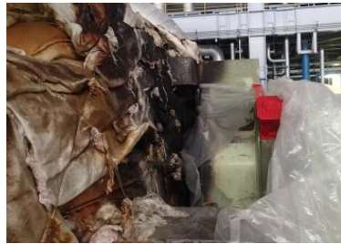
ケーシング内部の状況
