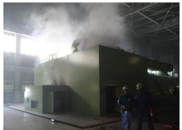
タービン出火状況
