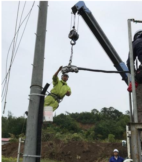
高压ケーブルによる応急送電
