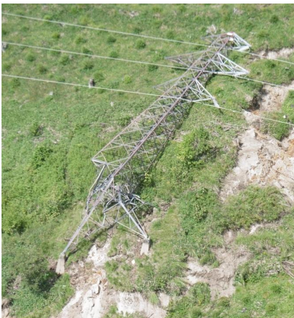
鉄塔倒壊箇所(岩知志線)
