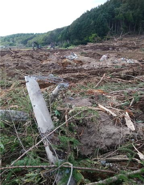
土砂崩れによる電柱流失
