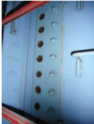
クレーンガーダ (ウェブ) : 中ボルトの更新
