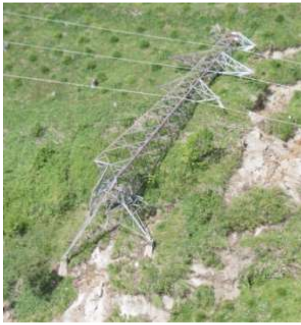
66kV岩知志線 鉄塔倒壊 (勇払郡むかわ町)
