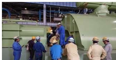
苫東厚真4号機：主タービン部での作業
