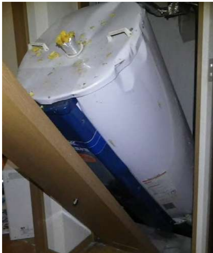
倒れた電気温水器(苫東厚真社宅)
