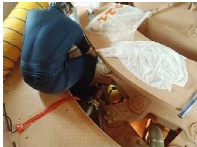
メーカーの協力の下、急ピッチで進めた修理 （京極2号機）
