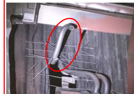
2号機: ボイラー管損傷状況②
