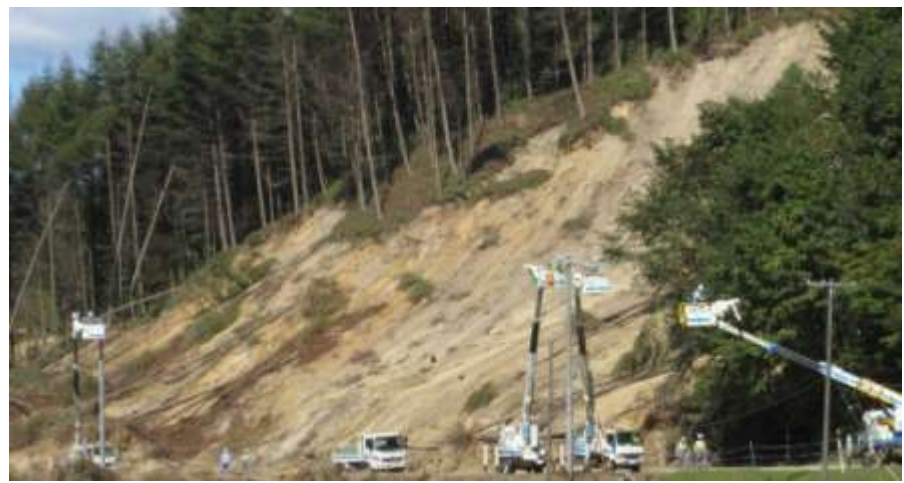
土砂崩れ箇所での復旧作業(厚真町幌内)
