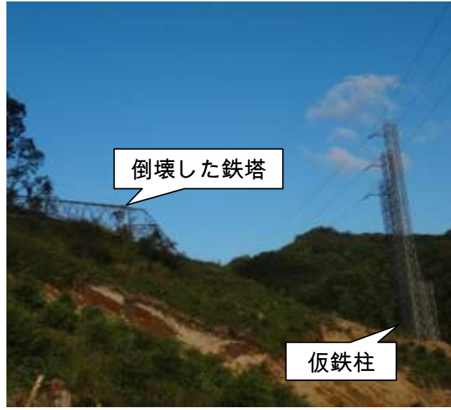
66kV岩知志線 鉄塔応急復旧状況
