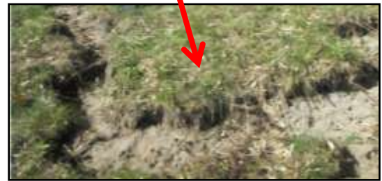
栄三西反射板（地割れが発生） C脚：20mm沈下,D脚：40mm沈下
