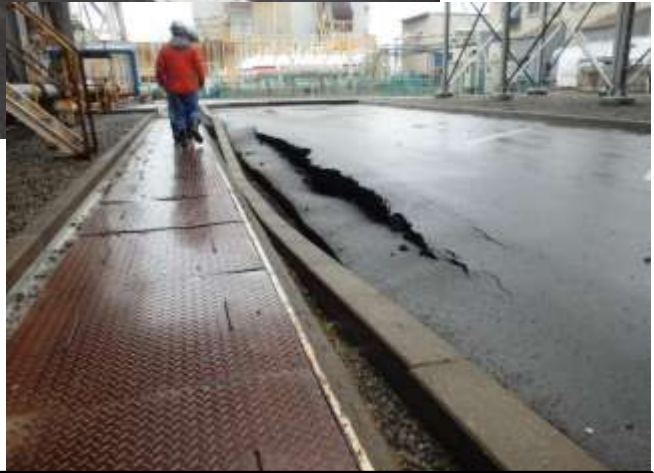
構内道路沈下
