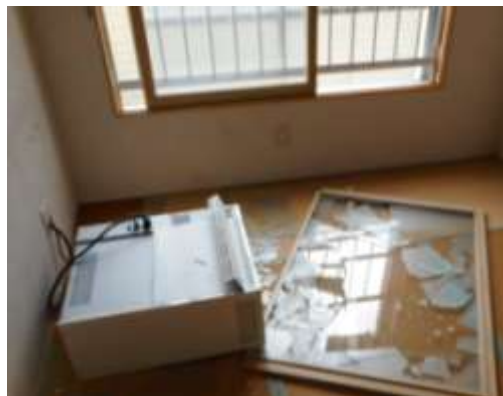
倒れた蓄熱暖房器と割れた窓ガラス (苫東厚真社宅)
