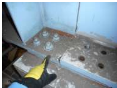
クレーンガーダ (フランジ) : ハイテンションボルトの更新
