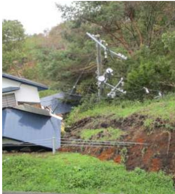
土砂崩れによる電柱傾斜 (勇払郡厚真町)
