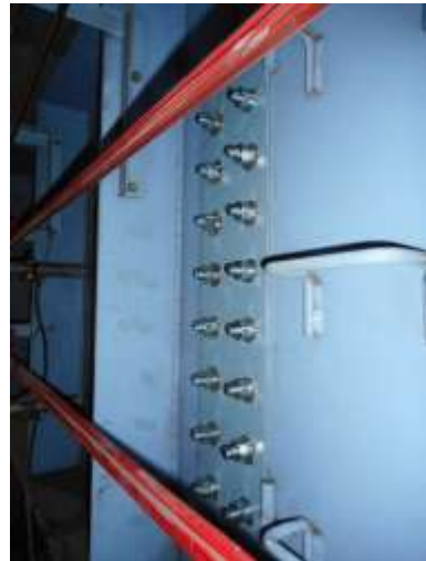
クレーンガーダ (ウェブ) : 中ボルトの更新
