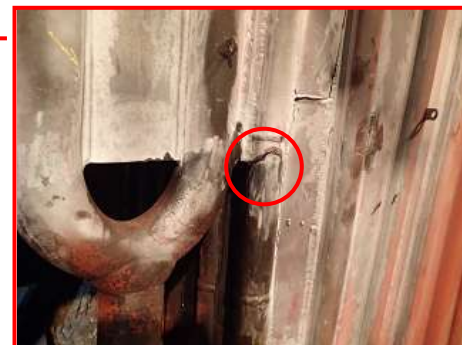
1号機: ボイラー管損傷状況
