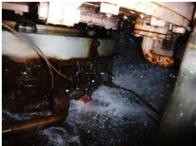
水車封水装置からの漏水 （京極1号機：9/2発生） ※地震による被害ではありません。
