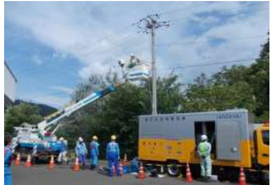
配電線への接続作業中の東北電力発電機車
