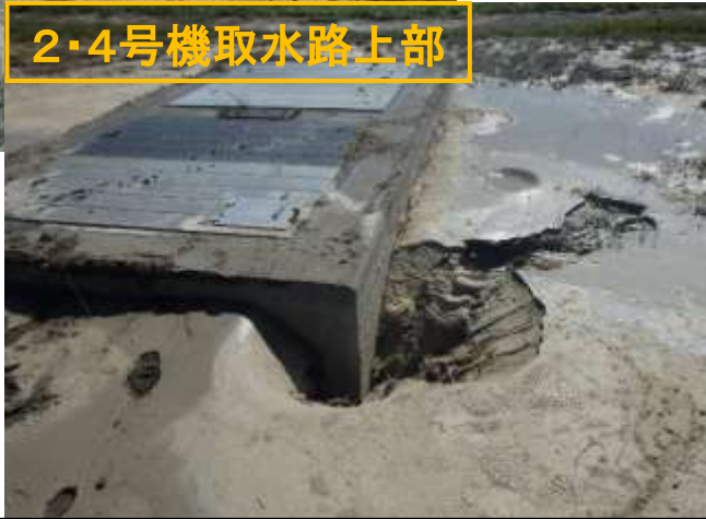
取水路上部地盤液状化
