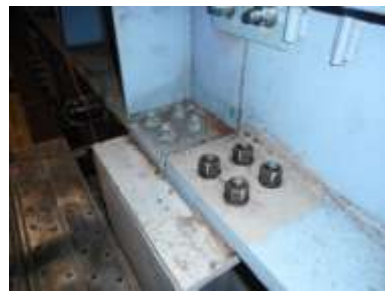
クレーンガーダ (フランジ) : ハイテンションボルトの更新
