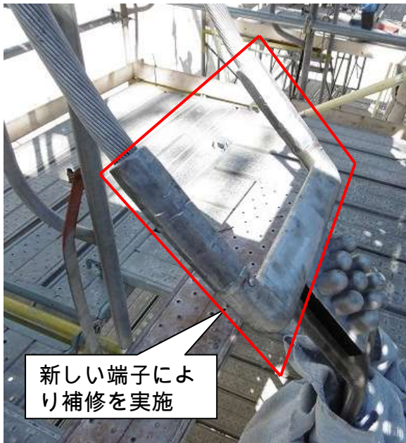
275kV南早来線 復旧（補修）状況
