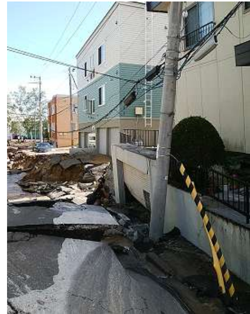
液状化により電柱が沈下 (札幌市清田区)
