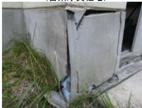
共用玄関部の破損(苫東厚真社宅)
