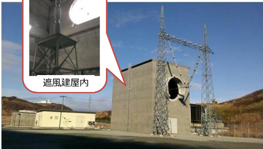
竜飛ケーブルヘッド遮風建屋
