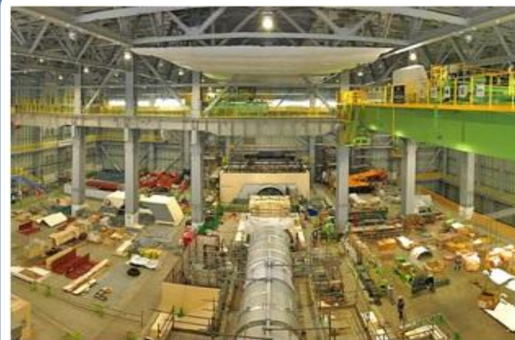
発電所本館内部
