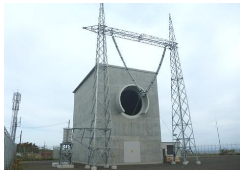
吉岡ケーブルヘッド遮風建屋
