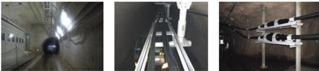
青函トンネル内における電力ケーブル等敷設状況
