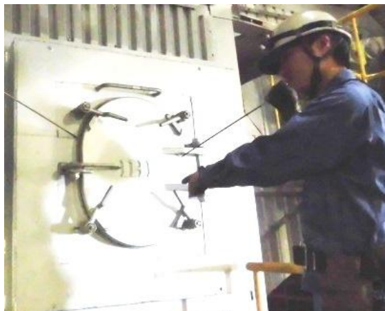
火力発電所の 日常巡視・点検
