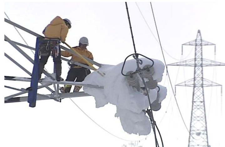
送電設備の雪落とし作業
