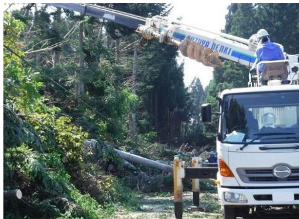
風雨により倒壊した 樹木の除去作業
