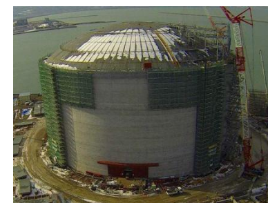
設置工事中のLNGタンク
