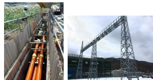
(工事中の送電設備)
