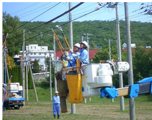
配電線の無停電工法の訓練 (電線の被覆剥ぎ作業)
