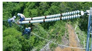
架空送電線の工事
