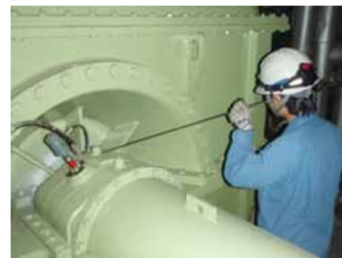
現場でのパトロール状況
