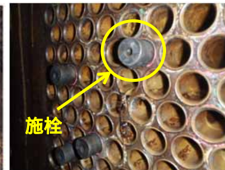
【写真】施栓状況
