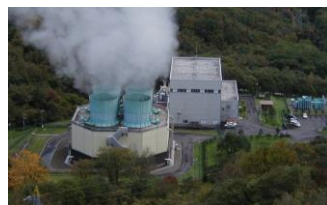
森地熱発電所
