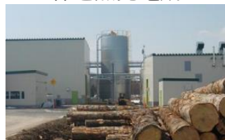
下川町木質バイオマス発電所
