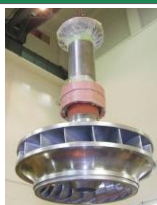
老朽化設備更新作業のようす
