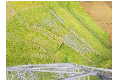
敷地監視状況
