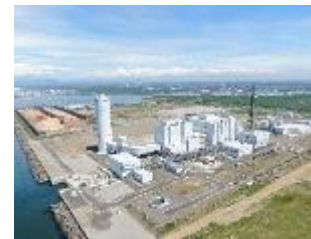
石狩湾新港発電所
