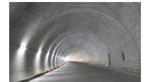
石炭灰を再利用したコンクリートによるトンネル覆工
