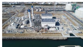
福島天然ガス発電所
