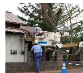
災害復旧の様子
