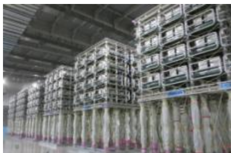
北斗変換所の変換器
