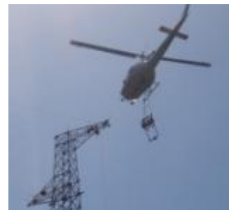
ヘリコプターを用いた送電線工事
