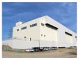
蓄電池建屋外観
