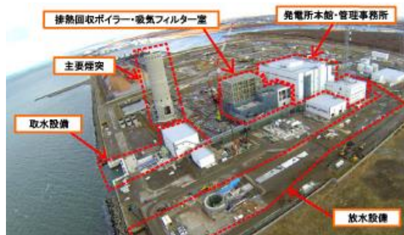
発電所工事エリアの全景
