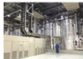
電解液タンク
