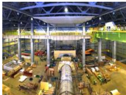
発電所本館内の工事状況
