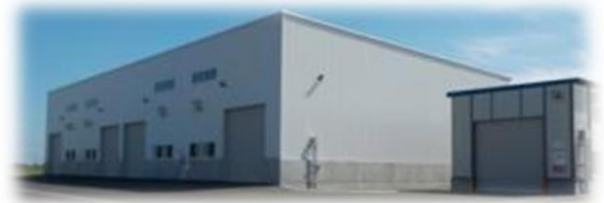
苫小牧リサイクルセンター
