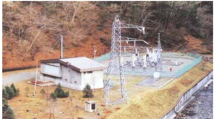
東の沢発電所全景
