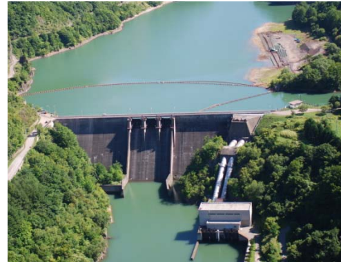
静内発電所全景
