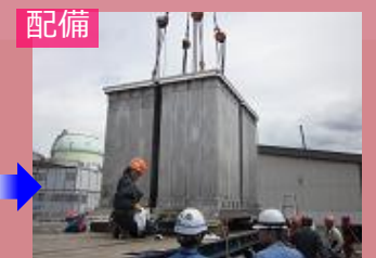
放射性物質吸着設備の配備
