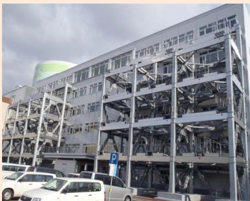
総合管理事務所耐震補強工事
