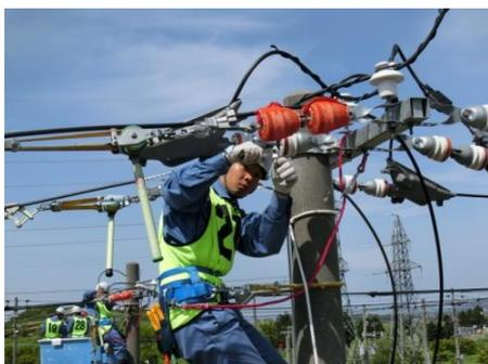
模擬柱を用いた高圧線新設訓練
