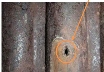
蒸発管損傷状況 長さ約 7mm×幅約 2mm
