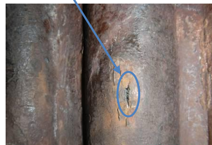
蒸発管損傷状況 長さ約 11mm×幅約 0.5mm
