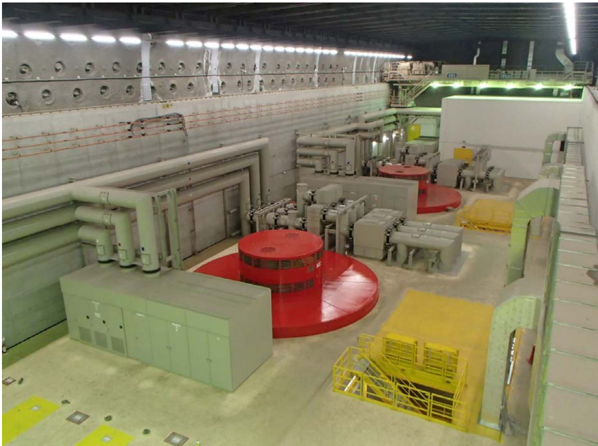
(手前：2号発電機、奥：1号発電機)
