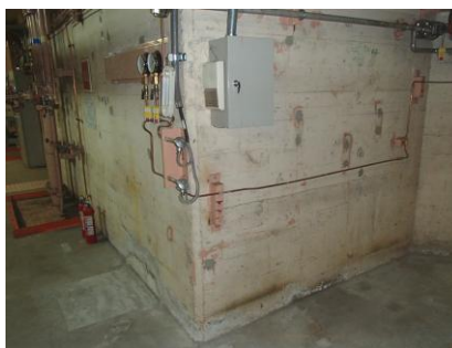
循環ポンプおよびろ過機撤去後
