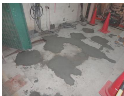
ろ過タンク撤去後
