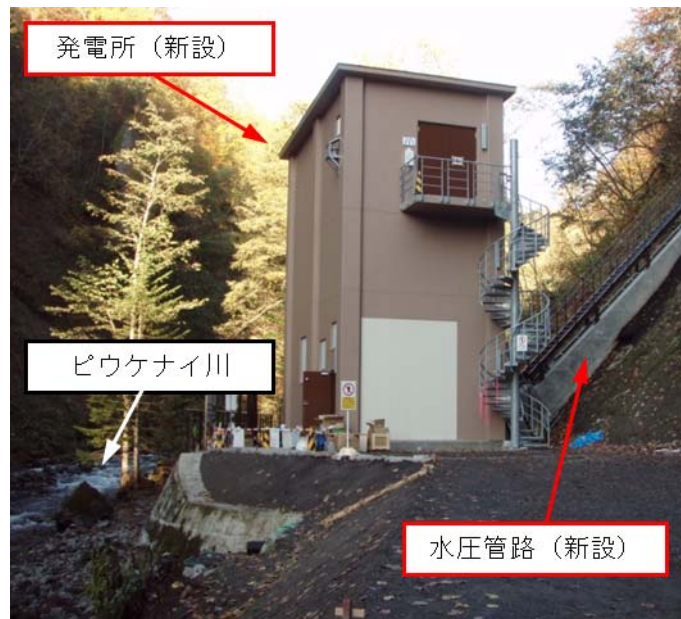
【ユコマンベツ発電所】
