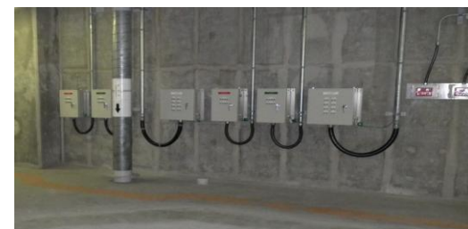
信号計測盤の設置状況
