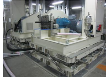
蒸気発生器直接給水ポンプの設置状況
