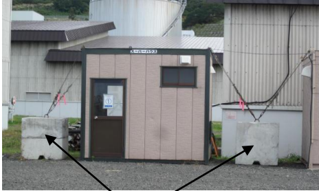
コンクリートブロックによる固定
