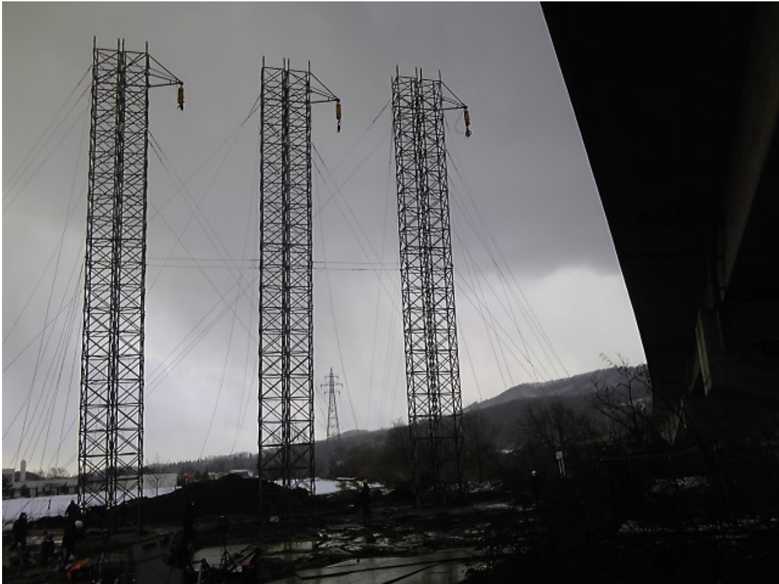
仮鉄柱 (No.29-1) 仮鉄柱組立状況
