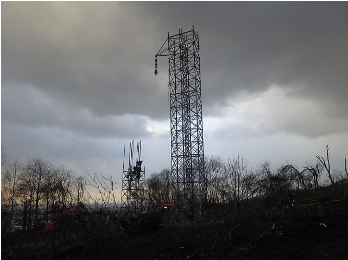
仮鉄柱 (No.29-2) 仮鉄柱組立状況
