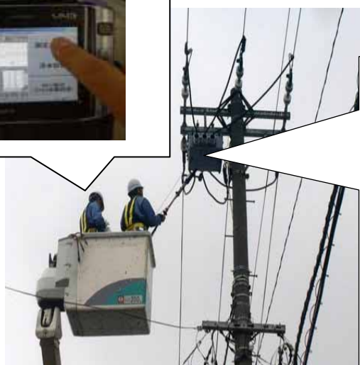
開閉器をハンマーで打撃し、打音を測定
