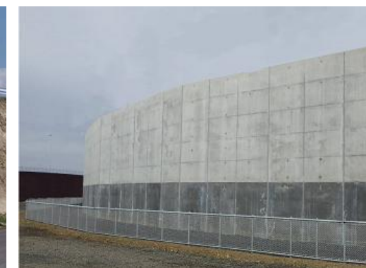
防潮堤（コンクリート壁区間）
