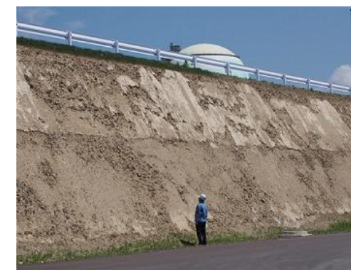
防潮堤（盛土区間）
