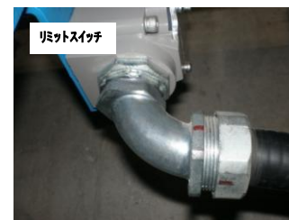
リミットスイッチ シール施工前
