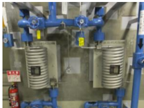
SGブローダウン冷却器補強前
