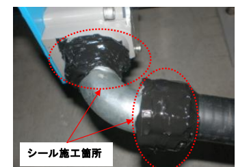
リミットスイッチ シール施工後
