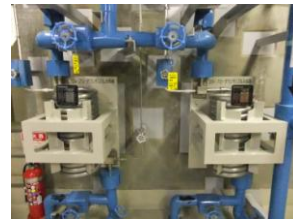
SGブローダウン冷却器補強後
