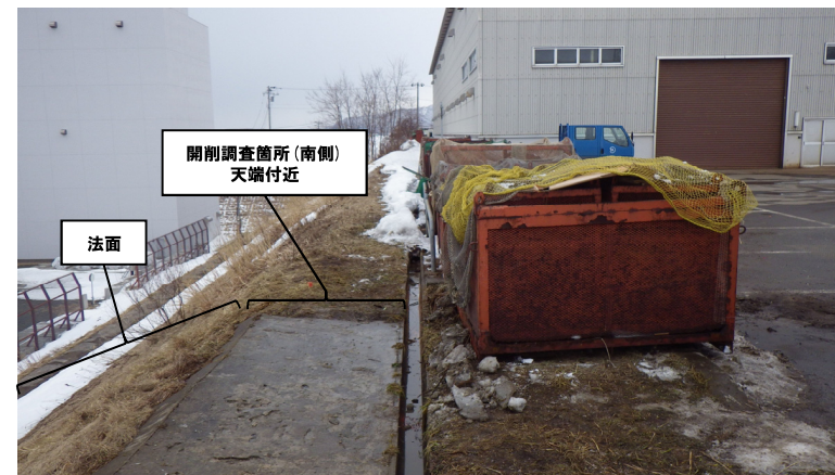
写真② 開削調査箇所(南側)付近法肩状況(平成25年3月撮影)
