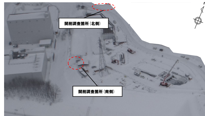
写真① 開削調査箇所(南側)付近空撮写真(平成27年1月撮影)
