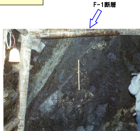
F-1断層露頭写真 (A-1坑) 始点からの距離254.9m (切羽)
