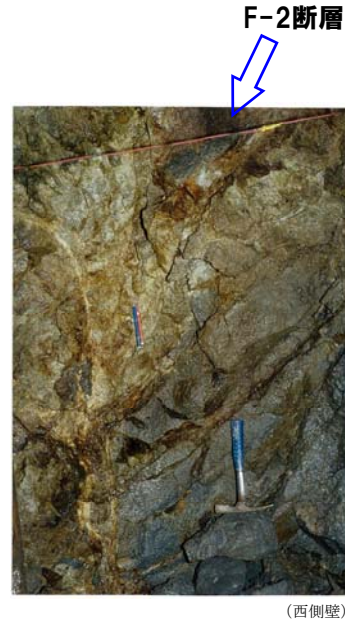
F-2断層露頭写真(A-2坑) 始点からの距離約204m
