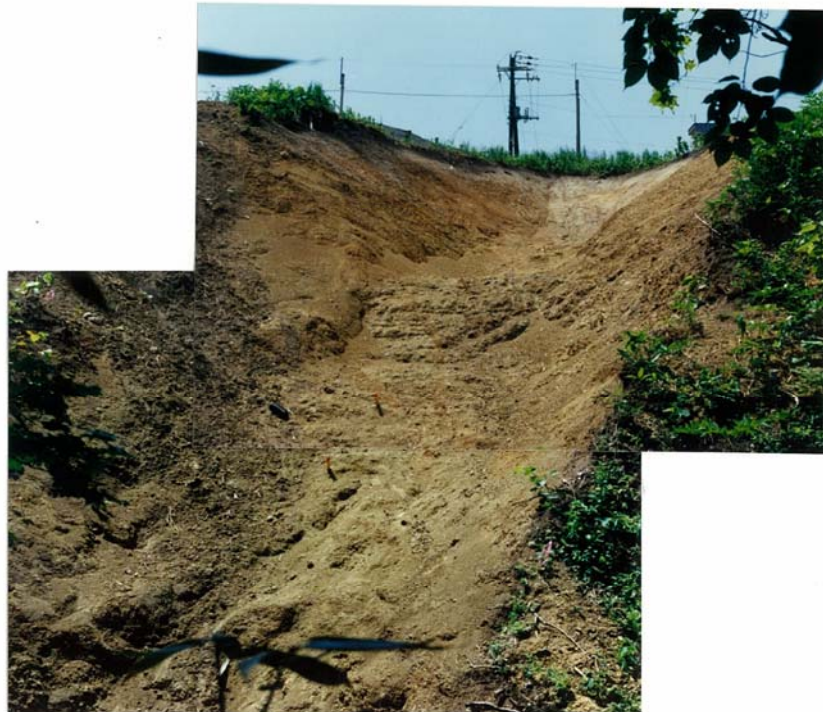
調査箇所全景
