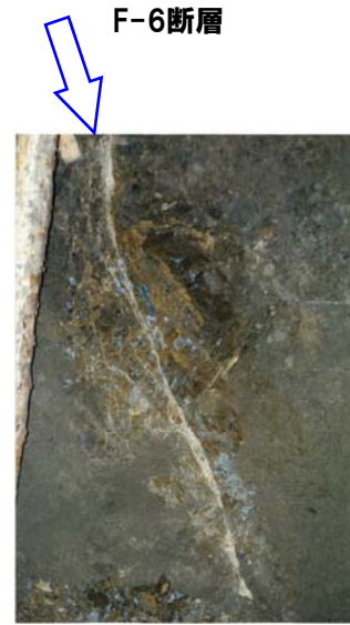
F-6断層露頭写真(No.9坑) 切羽
