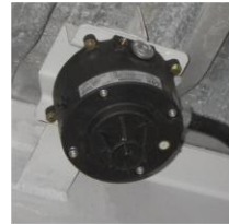
定温式スポット型熱感知器 (防爆型)
