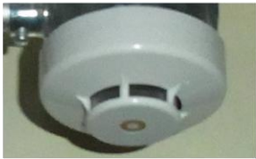
光電アナログ式スポット型煙感知器
