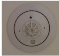
差動式スポット型熱感知器
