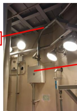
核計装電線管布設状況
