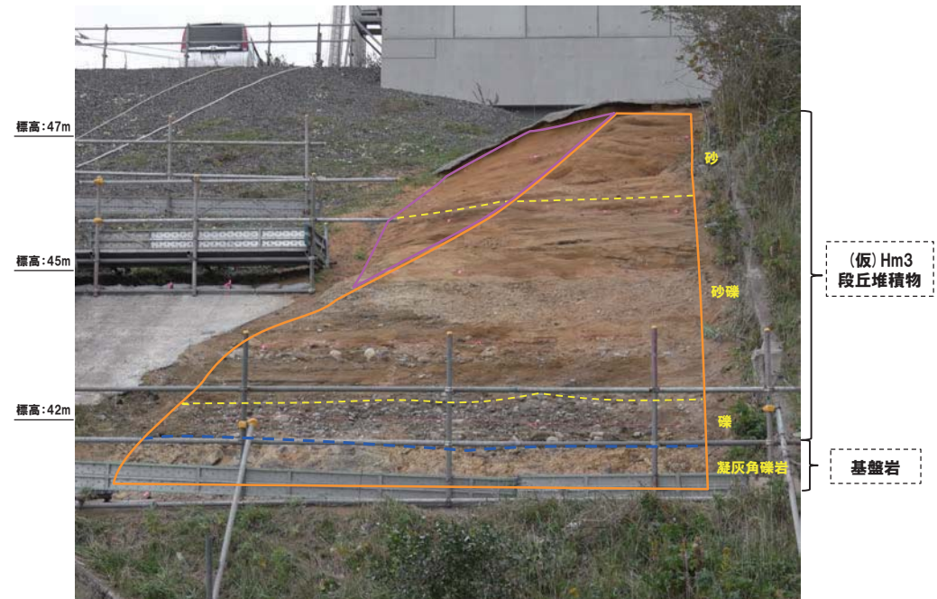
露頭拡幅部全景 (地層境界線あり)
