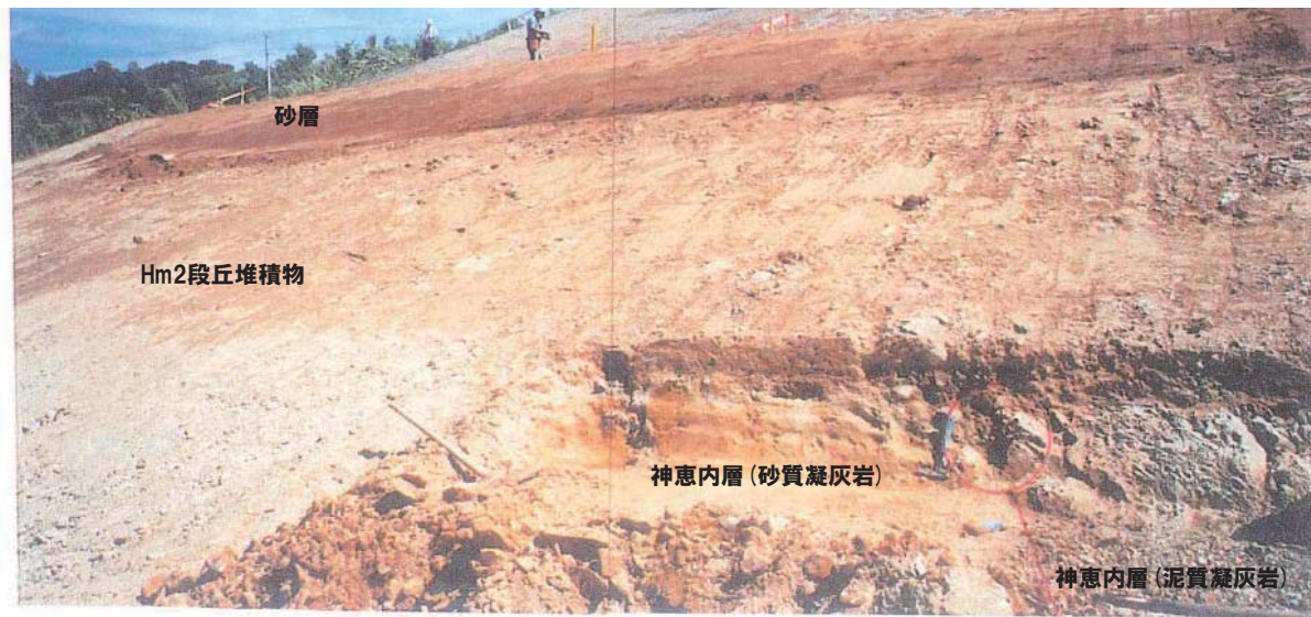
全景写真 (敷地造成工事時確認箇所)
