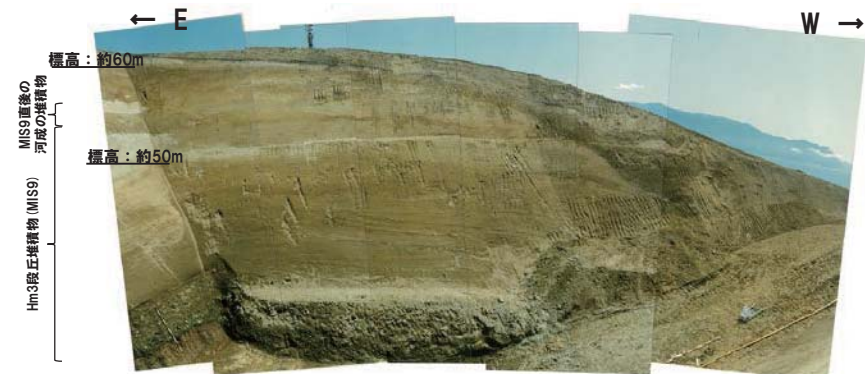
写真2 南側壁面を望む (昭和57年秋頃撮影)
