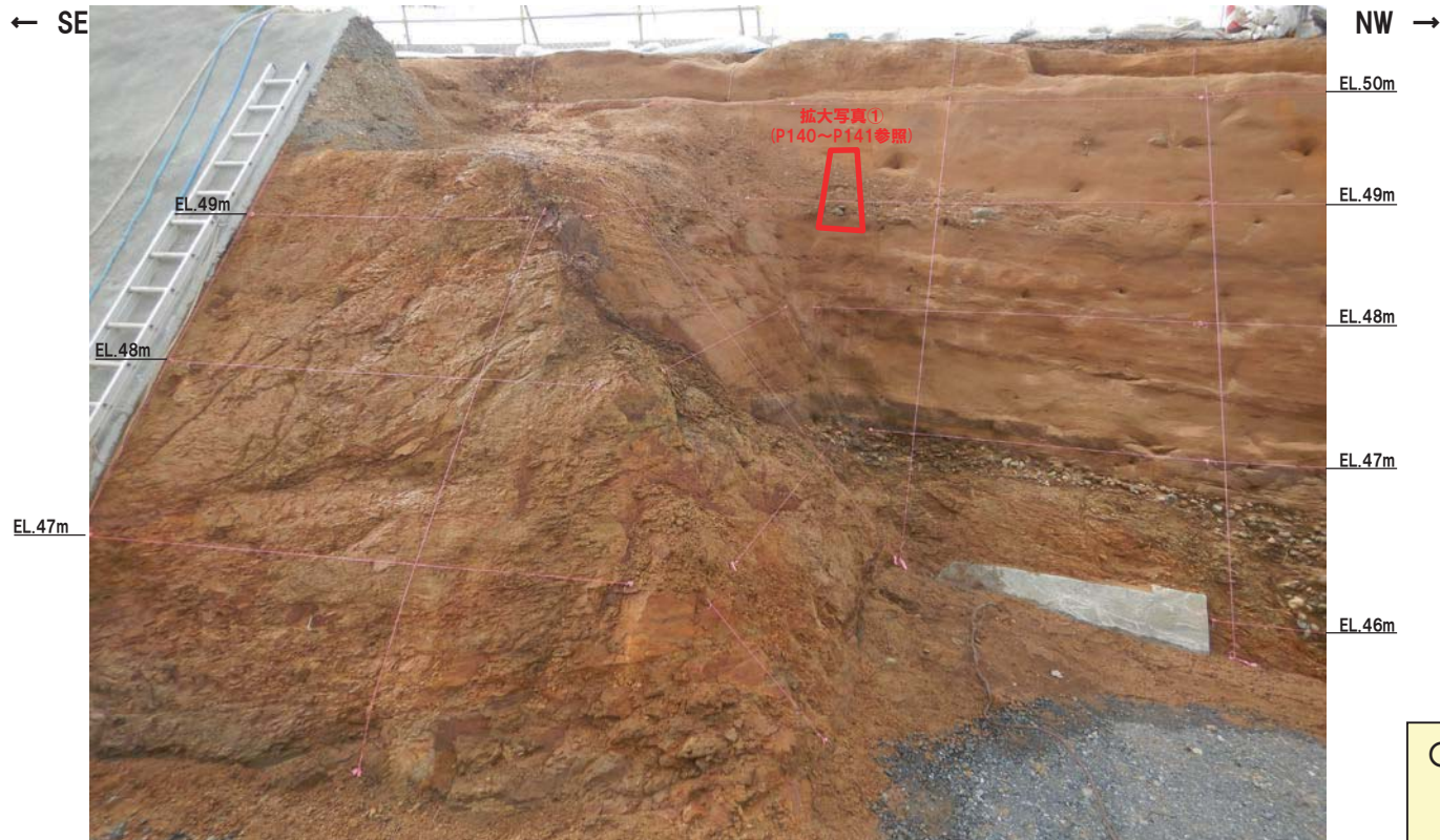
開削調査箇所(南側) 追加はぎとり調査写真(解釈線なし)
