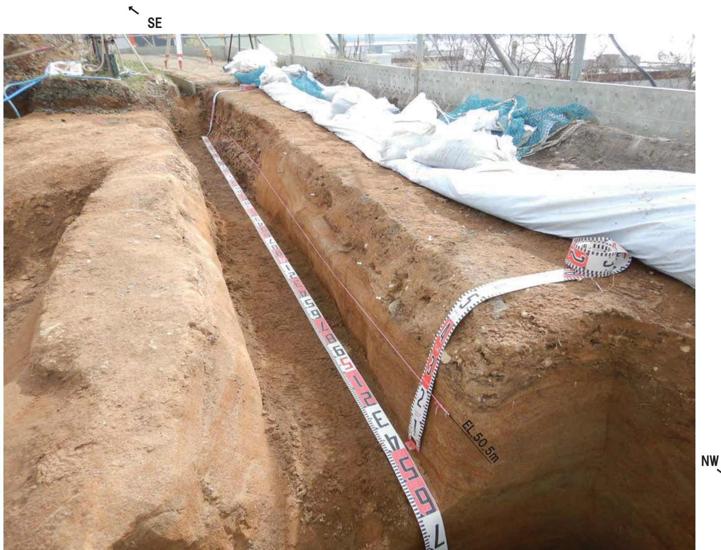
開削調査箇所(南側) 追加人力掘削調査 写真②(解釈線なし)
