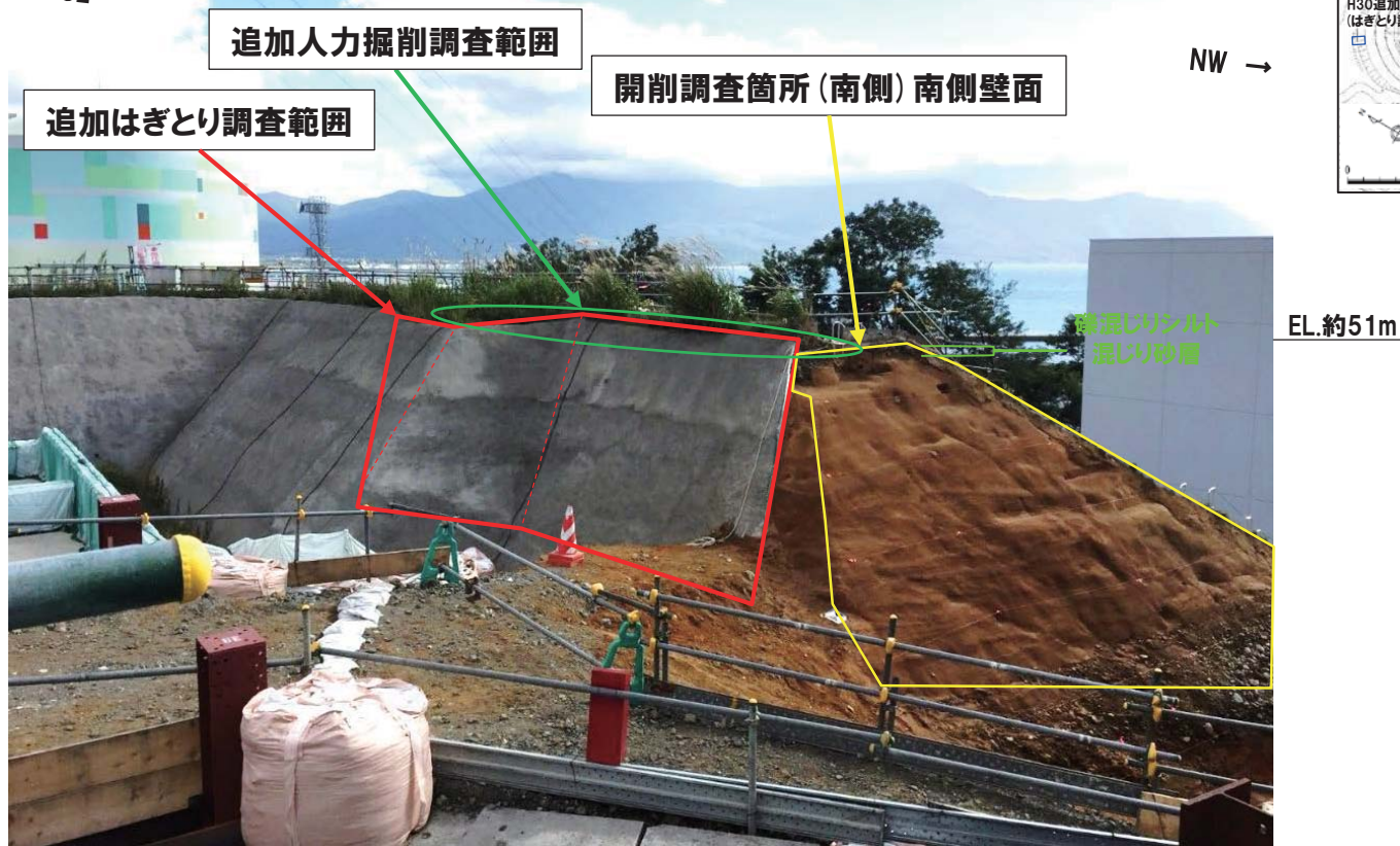
開削調査箇所(南側) 全景写真
