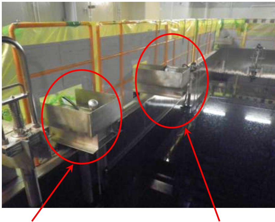
使用済燃料ピット温度 (AM用) 検出器
