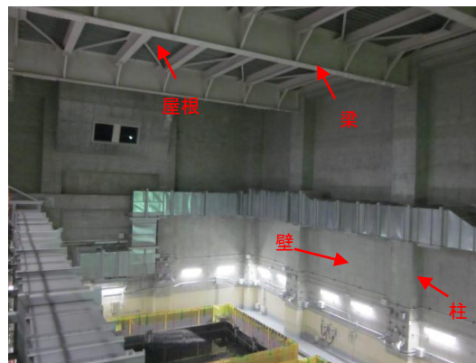
燃料取扱棟の屋根、梁、柱、壁
