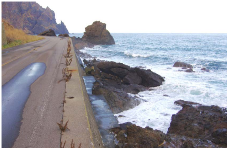
写真3~4の海岸の露頭状況
