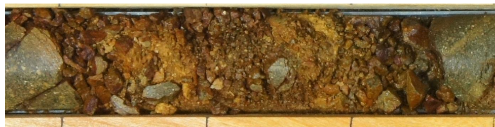
劣化部拡大写真(深度6.05～6.40m)
