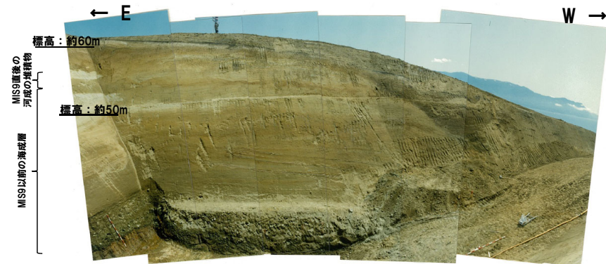
写真2 南側壁面を望む (昭和57年秋頃撮影)
