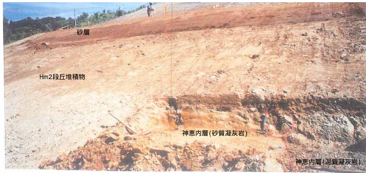
全景写真(敷地造成工事時確認箇所)
