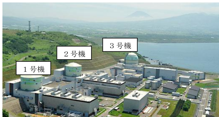
図-1-2 泊発電所全景写真
