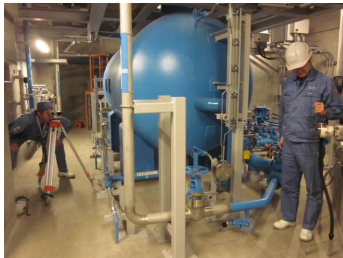
図-4 計装類 (原子炉補機冷却水サージタンク水位)
