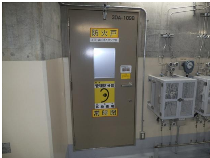
(5) B-高圧注入ポンプ室扉
