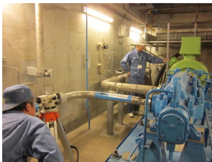
図-2 ポンプ類（電動補助給水ポンプ）
