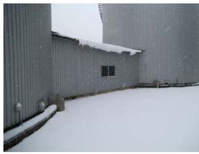
3号純水タンク防雪小屋② (同道までの深さ約1.4m)
