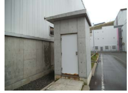
点検口① (洞道までの深さ約1.5m)
