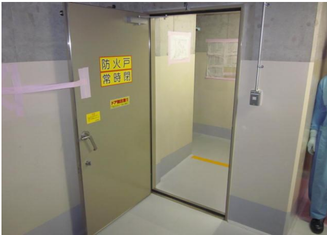
(1) B-安全補機配管室扉
