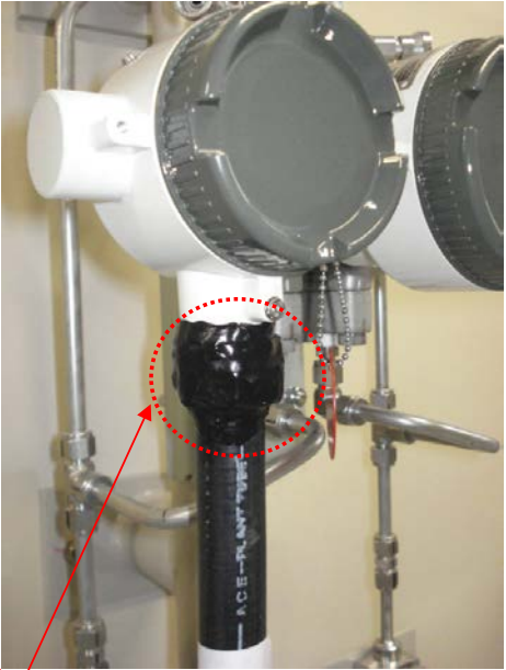
シール施工箇所
