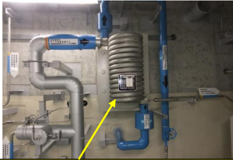
格納容器雰囲気ガスサンプル冷却器
