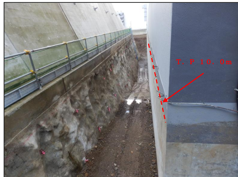
図4 土壌入替え時の掘削状況
