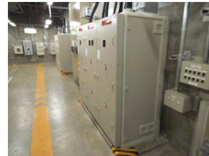
盤シール工事の完成状態(2号機例)
