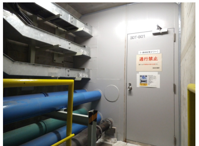
図4 タービン建屋連絡扉①
