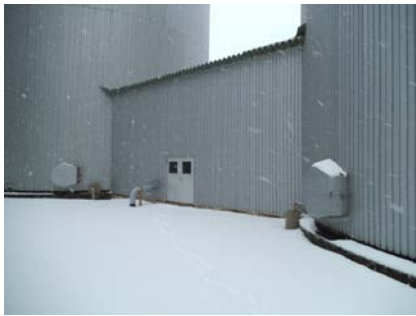
3号ろ過水タンク防雪小屋① (同道までの深さ約1.4m)
