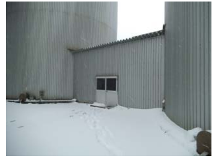
1・2号純水タンク防雪小屋③
