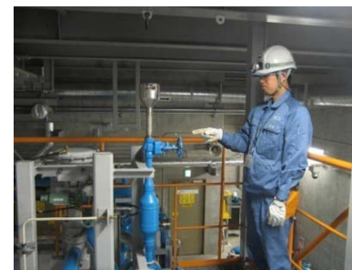
手順7: 格納容器自然対流冷却(補機冷却水サージタンク室素加圧) (原子炉補機冷却水サージタンク薬品添加口止め弁操作訓練)
