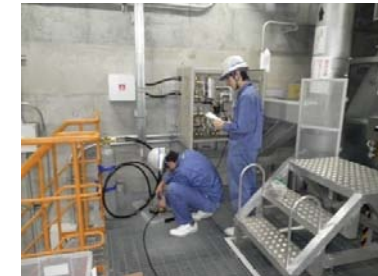
主蒸気逃がし弁N 2 ポンベ接続教育訓練
