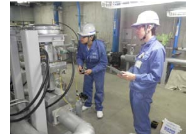
主蒸気逃がし弁N 2 ポンベ接続教育訓練
