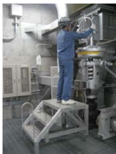
手順2: 2次系強制冷却操作 (主蒸気逃がし弁開操作訓練)
