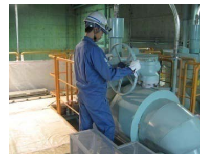
手順12:原子炉補機冷却海水系統への給水 確保(海水)(系統構成操作訓練)
