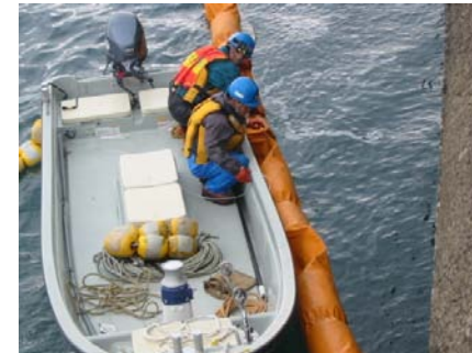
シルトフェンス設置教育訓練
