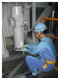
手順6: 被ばく低減操作(アニュラス空気浄化ファン タンパ室素供給)(アニュラス空気浄化ファン室 アニュラス排気タンパ手動ハンドル操作訓練)
