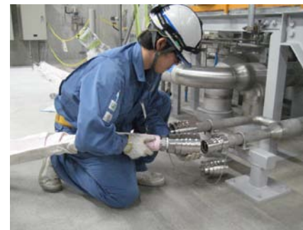
代替給水・スプレイ等操作系统構成教育訓練 (SGへの給水)
