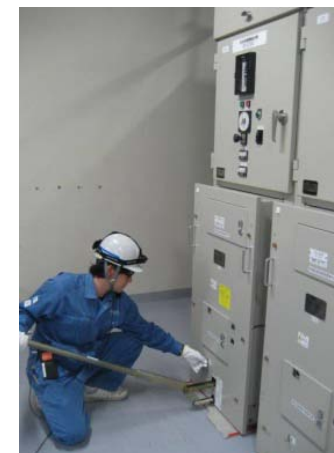
代替給電操作訓練 (電源確保)
